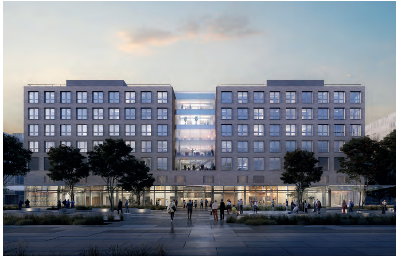
CHU de Rennes, Centre Chirurgical et Interventionnel (CCI) / © Brunet Saunier & associés. Conseil en architecture de santé pour SOGEA Bretagne BTP
